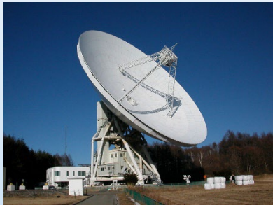
野辺山 1982～ ・口径45mミリ波望遠鏡：日本初の大型ミリ波電波アンテナ技術を確立
