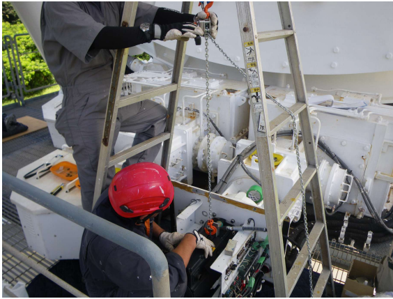
図5 EL モーター交換の様子
