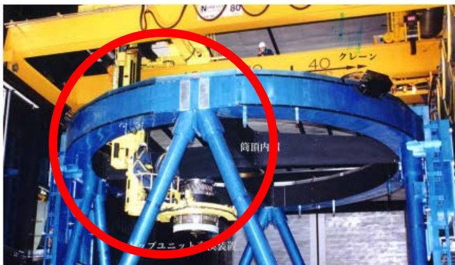
改修箇所と足場
